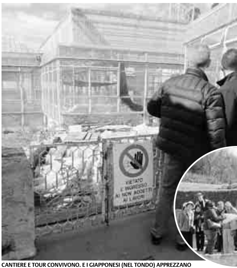
CANTIERE E TOUR CONVIVONO. E I GIAPPONESI (NEL TONDO) APPREZZANO
